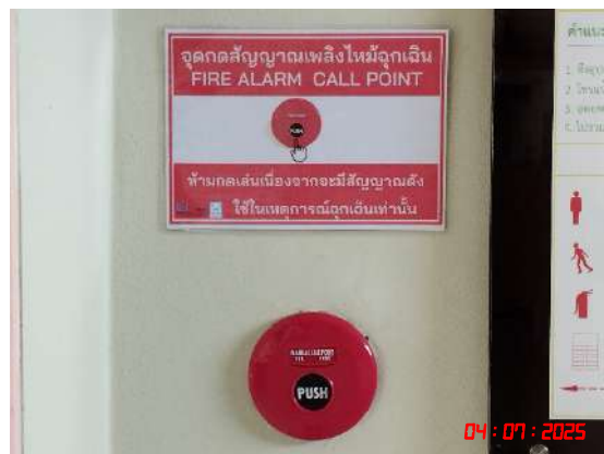
ระบบแจ้งเหตุเตือนภัยแบบใช้มือกด
