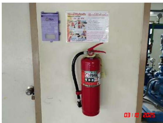
ถังดับเพลิงเคมีชนิดมือถือพร้อมวิธีการใช้ถังดับเพลิง
